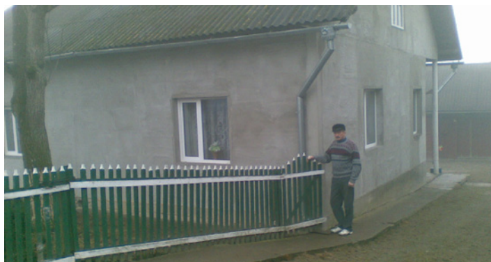
Dom ukrajinskej rodiny v obci Velesniv pred rekonštrukciou a po zateplení a výmene okien. Foto: Rudyk Bogdan
